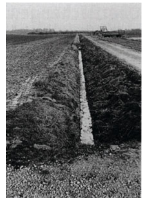
Abb. 2. Nördliche Dansweiler Ronne, Gewässerausbau 1965 als Vorflut für die Oberflächenentwässerung der Außenkippe „Glessener Höhe“ (Photo 1994)
