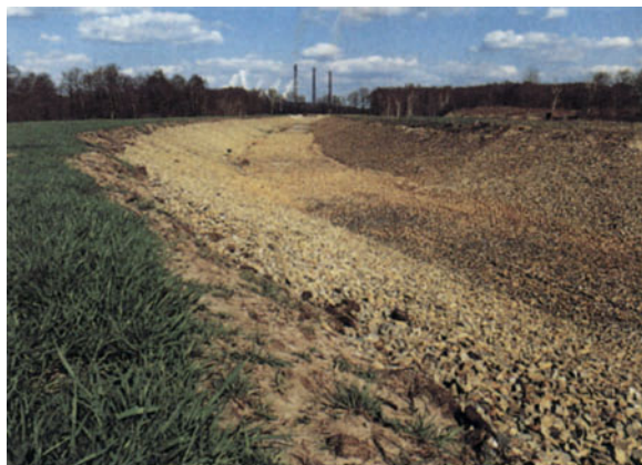
Abb. 3. Der Schotterabdeckung des neuen Grabenverlaufes folgen später Bentofixmatten. (Photo: LAUBAG)
