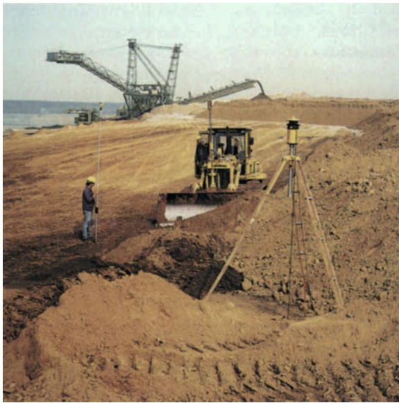
Abb. 4. Lasereinsatz in der landwirtschaftlichen Wiedernutzbarmachung (Photo: Rheinbraun)
