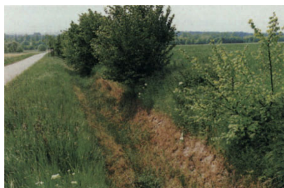
Abb. 4a, b Gewässerausbau 1982 im Tagebau Fortuna-Garsdorf (Wiedenfelder Höhe). In einer starken Gefällestrecke wurde der Graben bis zum Berechnungshochwasserspiegel mit Bruchsteinpflaster in Beton befestigt. Später wurde eine einreihige Bepflanzung in der oberen Böschungshälfte vorgenommen. 1993/94 wurde nachträglich ein 3 m breiter Uferstreifen angelegt und mit Pfosten markiert. Ein derartiger Ausbau ist heute nicht mehr üblich. Die Bilder wurden jeweils vom gleichen Standort aufgenommen
