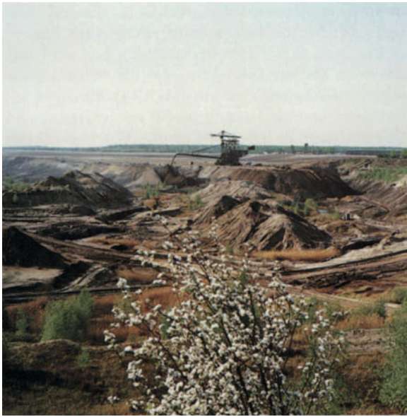
Abb. 5. Böschungsanstützung in einem Tagebaurestloch (Tagebau Goitsche, 1993)
