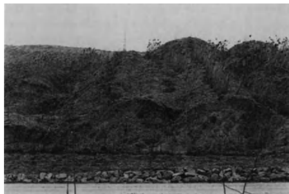
Abb. 5. Mit Großabsetzer verkippter Forstkies auf der Sophienhöhe
