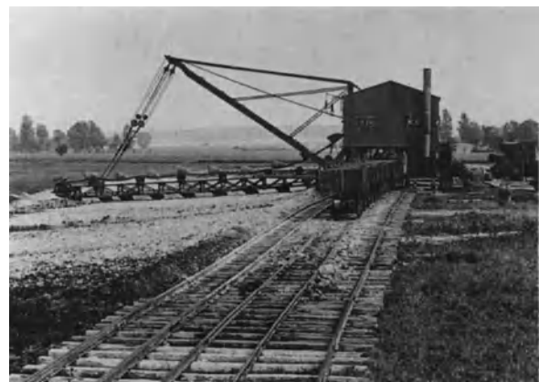
Abb. 1. Mutterbodenanschnitt/Eimerkettenbagger mit Dampfantrieb (Grube Leopold bei Bitterfeld, 1908)
